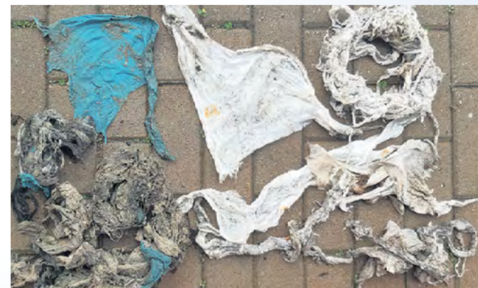
Ausbeute aus einem Pumpwerk im Wiesenring: Immer wieder holt das Team vom WAZV Stoffreste, Feuchttücher und anderen Abfall aus Pumpwerken und Rohrleitungen. Foto: WAZV
