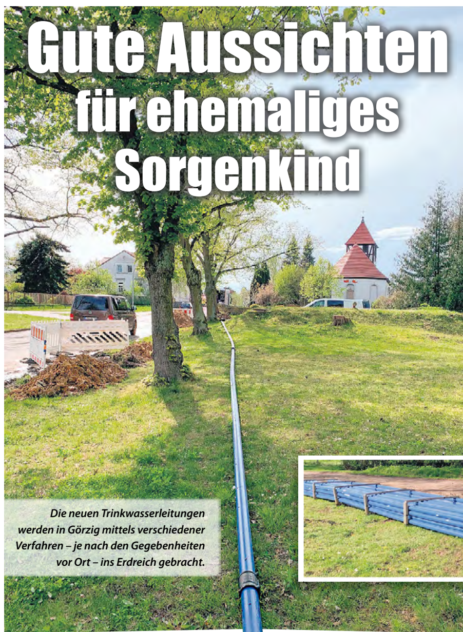
Bereit für den Einsatz. Die PE-Rohre sind weniger anfällig für Schäden und sollen die Trinkwasserversorgung sichern.
