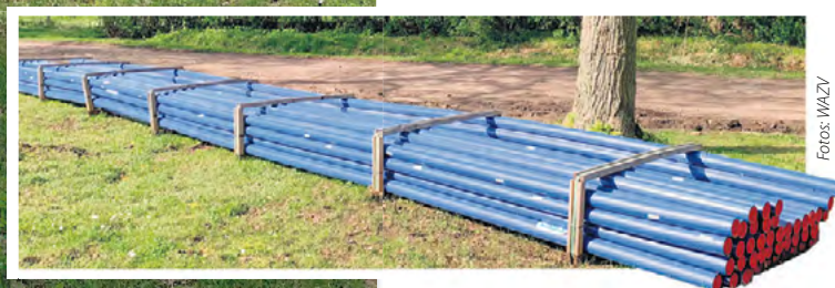
Bereit für den Einsatz. Die PE-Rohre sind weniger anfällig für Schäden und sollen die Trinkwasserversorgung sichern.
